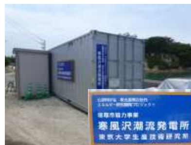
潮流発電装置の設置(2014.11.18)
