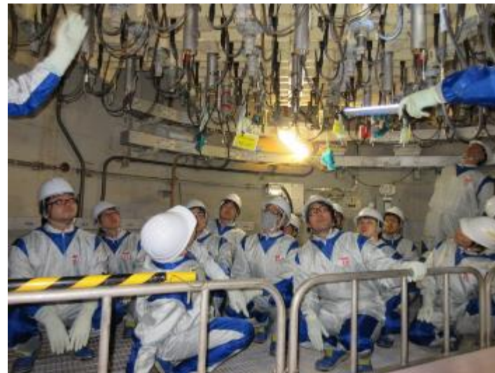
制御棒の真下部分を見学
