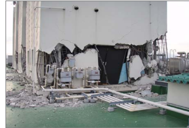
工学研究科電子・応用実験棟 塔屋の崩壊
