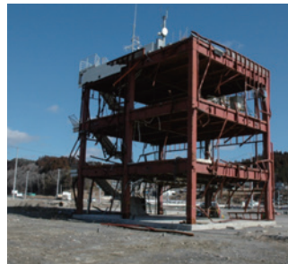
●3Dレーザー Scannerによる測量作業
