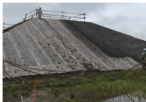
津波堆積物中の粘土を用いて作成した緑化基盤材による法面緑化工事 Construction of embankments utilizing the planting soil obtained by from parts of the tsunami debris.
