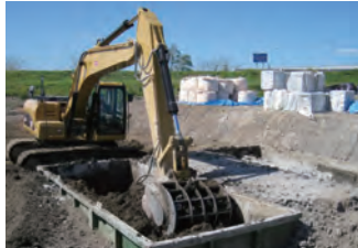
繊維質固化処理土工法による津波堆積物の再資源化 Reutilization of tsunami debris via fiber-cement-stabilized soil method.
