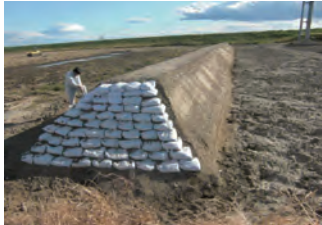
繊維質固化処理土を用いて造成された堤防 Dike constructed with fiber-cement-stabilized soil.
