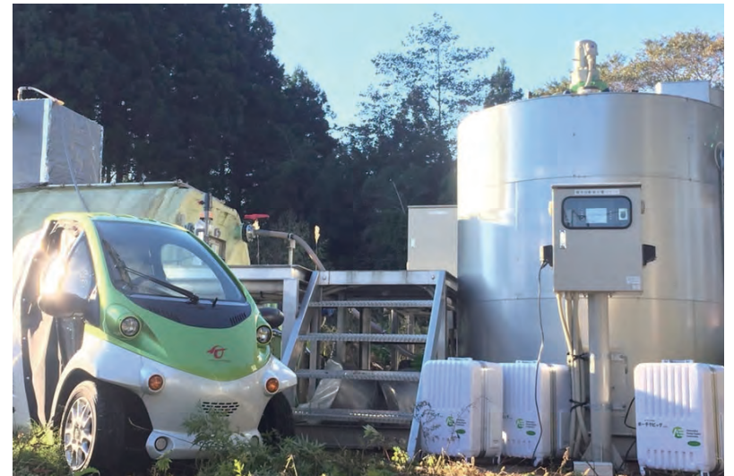
バイオガス燃料による小型電気自動車への充電 Charging a small electric car with produced biogas fuel.
