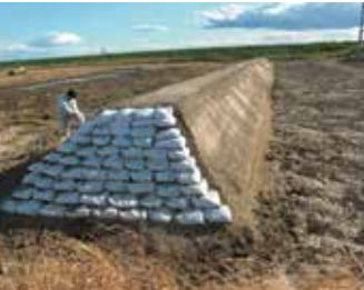
繊維質固化処理土を用いて造成された堤防
