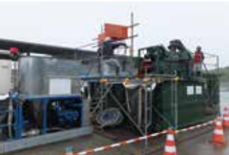
ソイルセパレータマルチ工法による津波堆積物の分級
