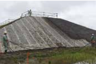
津波堆積物中の粘土を用いて作成した緑化基盤材による法面緑化工事
