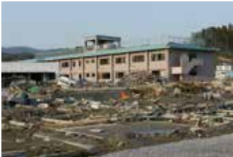
津波で廃墟と化した気仙沼市沿岸地域。後ろは被災した介護老人保健施設。
